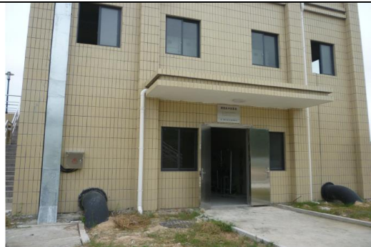
滤池反冲洗泵房
